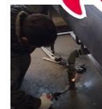
排水管が金属製の場合はガスバーナーで錆び落とし、はずします。
