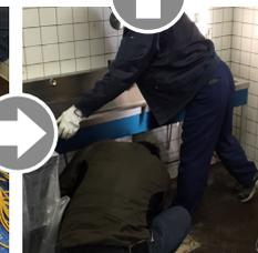
施工時間は約4時間。床補修はモルタル仕上げ。1500xD450xH800のワイドサイズ。冬に嬉しい専用の給湯器も設置。
