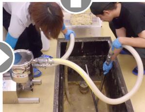
①配水管につながるシンク槽の排水口から油脂などを吸引し専用の石鹼化ケミカル剤を混ぜ石鹼水に変え、配水管の汚れを除去します。
